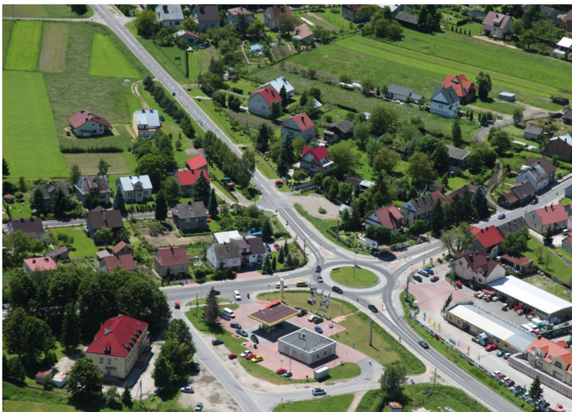
Fotografia 7. Modernizacja drogi wojewódzkiej nr 980 Jurków - Biecz
