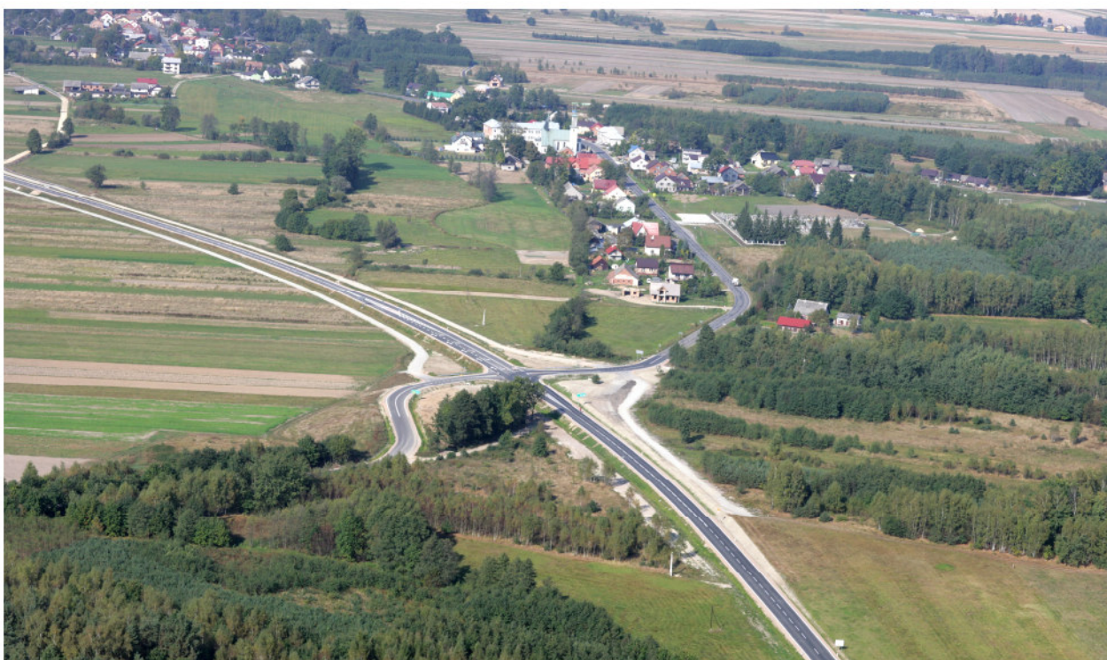
Fotografia 10. Budowa obwodnicy Szczurowej
