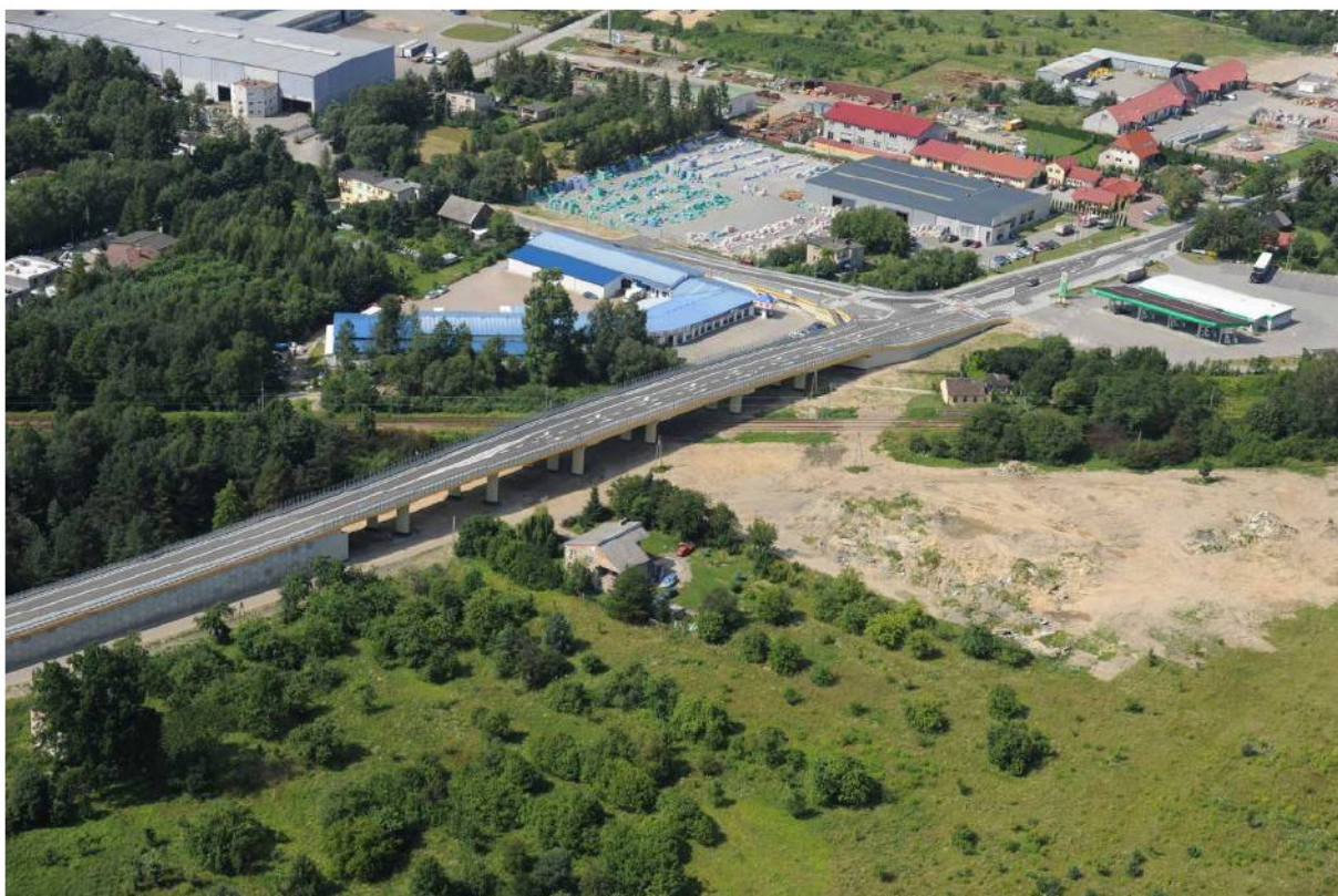
Fotografia 9. Modernizacja drogi woj. nr 933 na odcinku Brzeszcze - Chrzanów wraz z budową wiaduktu w m. Kroczykach.
