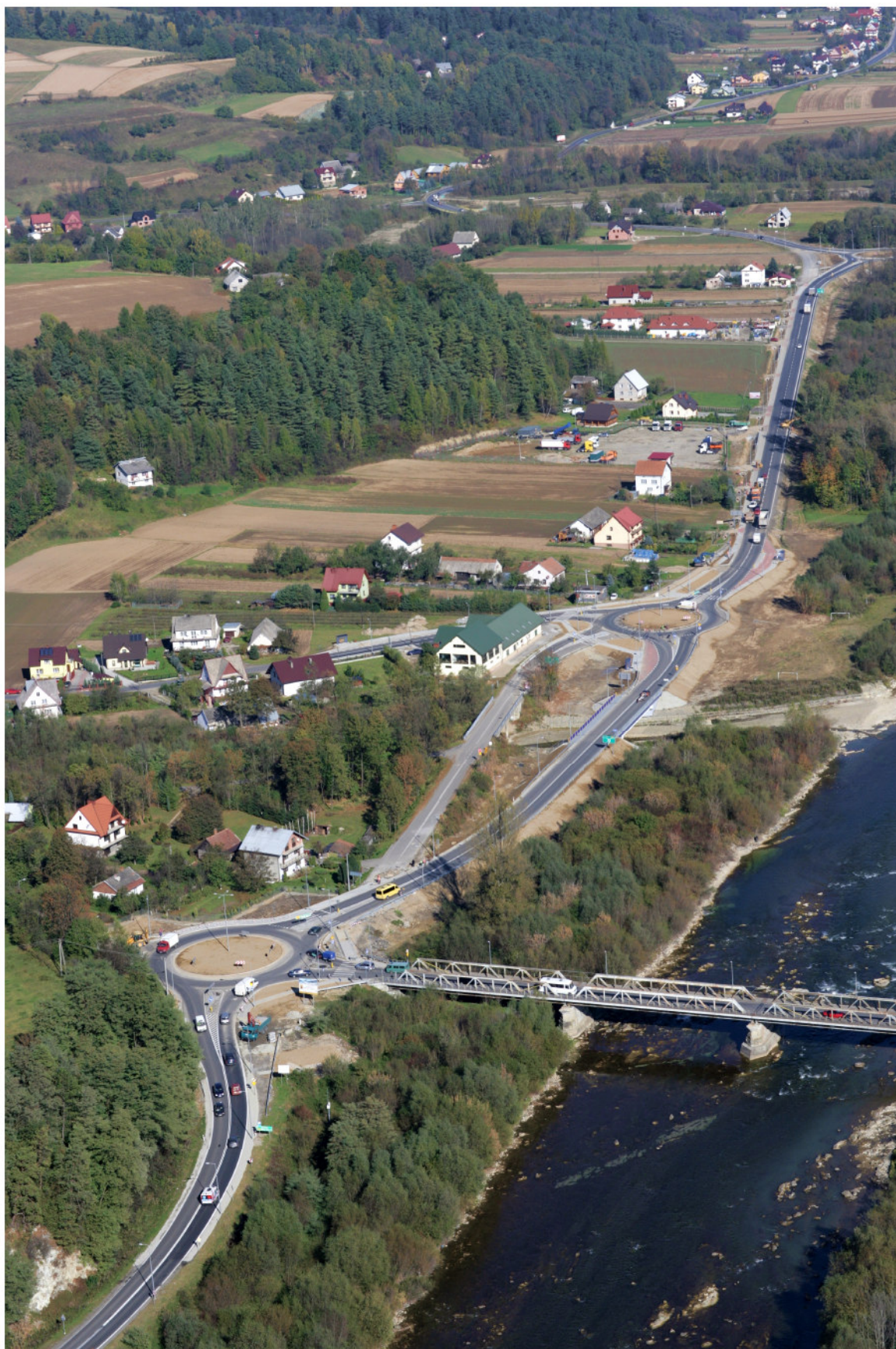
Fotografia 8. Budowa obwodnicy Podegrodzia
