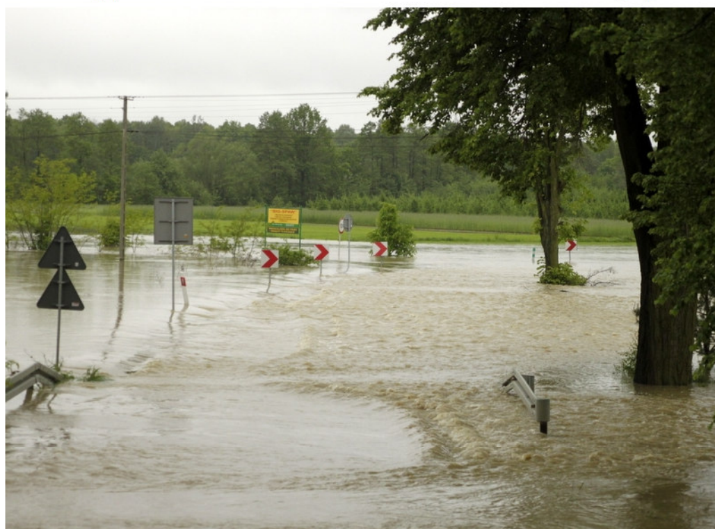
Szkody powodziowe na DW 982
