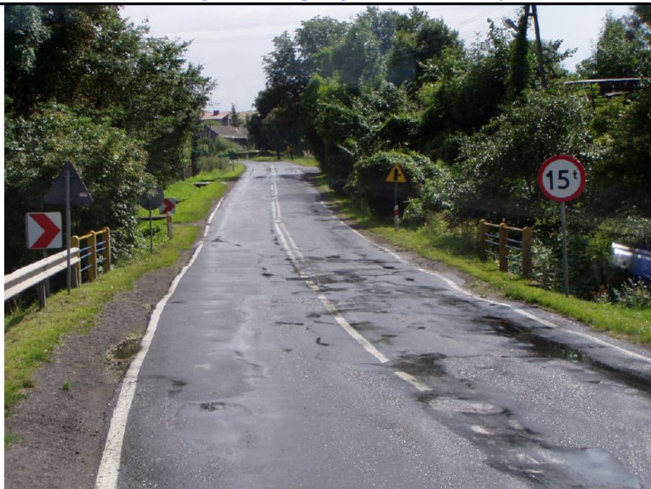
Fotografia nr 5. Przebudowa DW nr 783 na odcinku Wolbrom – Miechów. Fotografia wykonana przed realizacją Projektu.
