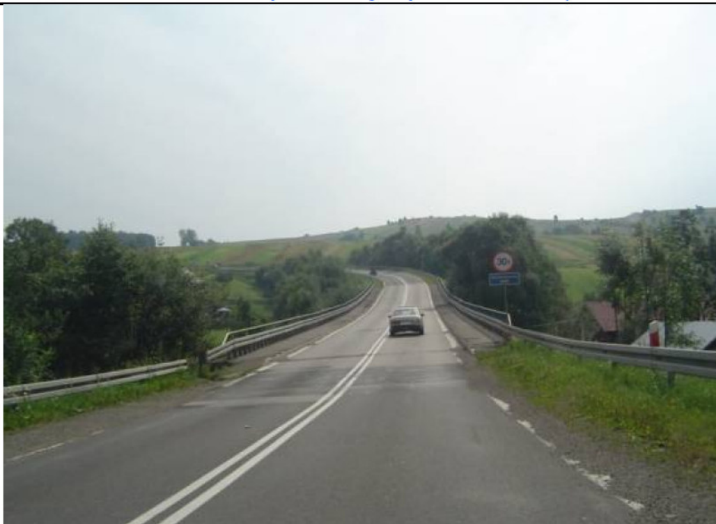
Fotografia nr 6. Budowa mostu wraz z dojazdami w ciągu DW 969 w m. Kluszkowce. Fotografia wykonana przed realizacją Projektu.
