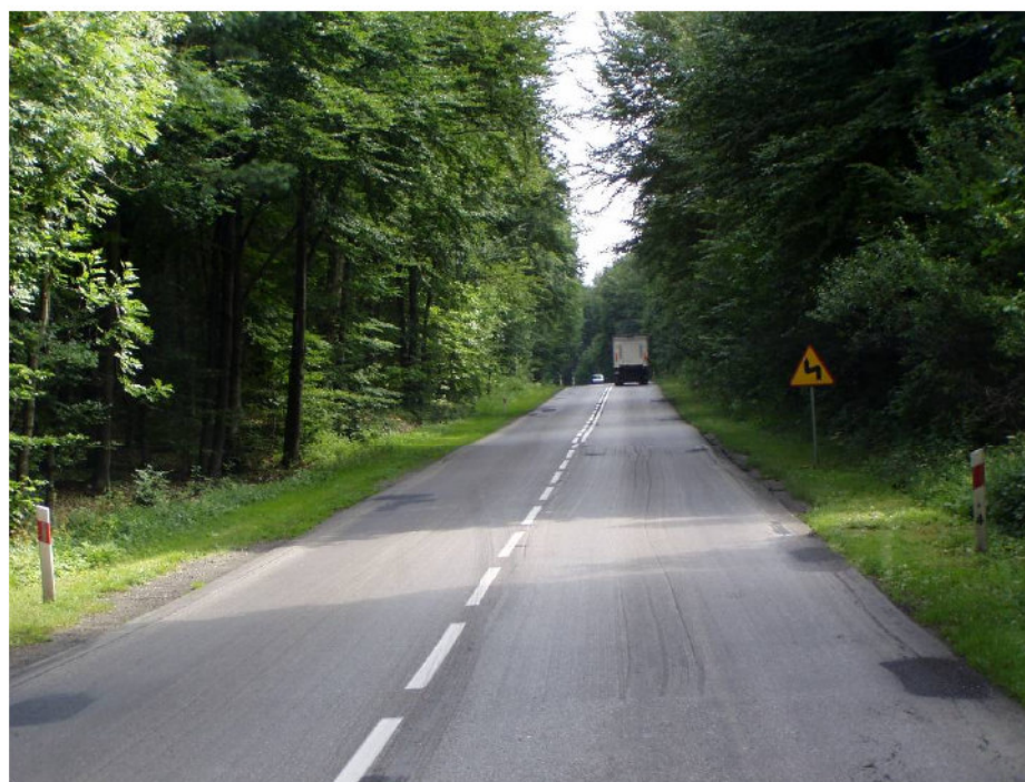
Fotografia nr 4. Przebudowa DW nr 783 na odcinku Olkusz - Wolbrom. Fotografia wykonana przed realizacją Projektu.
